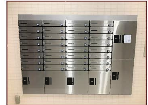
宅配ボックス設置しました！
